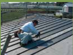
屋根材をガルバニウム鋼板での施工
